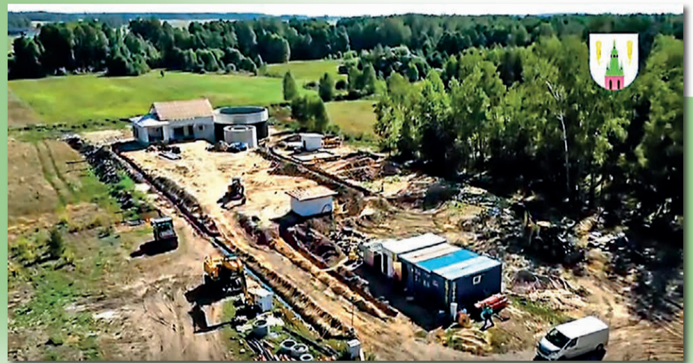
Plac budowy Gminnej Oczyszczalni Ścieków
