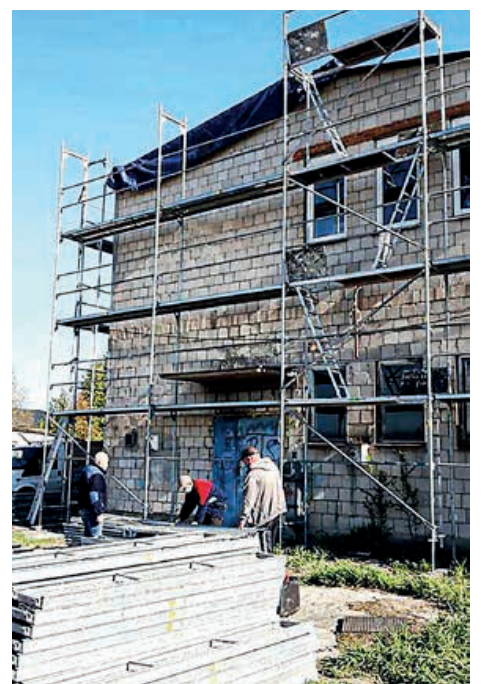
Ustawianie rusztowań na budynku w Brójcach rozpoczęło 20 kwietnia br.
