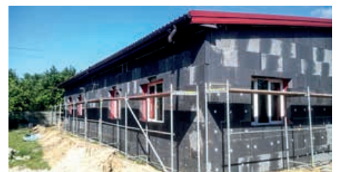
Pracownicy firmy ENERGO-BUD najpierw gruntownie zabezpieczyli i zaizolowali fundamenty budynku
