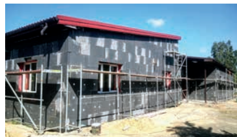
Elewację ocieplono styropianem o grubości 15 cm i współczynniku przewodzenia ciepła \lambda=0,036 W/mK
