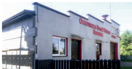
Termomodernizacja strażnicy w Bukowcu zaczęła się na początku maja br.
