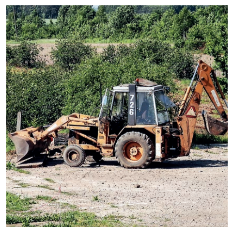
Z placu w Brójcach usunięto betonowe płyty i gruz
