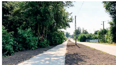
Prace przy układaniu nowego chodnika w Bukowcu rozpoczęto 26 kwietnia br.
