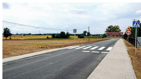
Wyremontowany fragment drogi Wardzyn-Palczew
