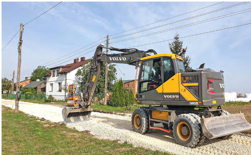
Prace na Folwarcznej, 19 sierpnia br.
