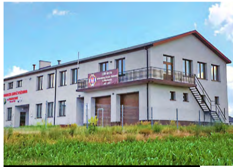
Świetlica powstaje w budynku OSP Wardzyn
