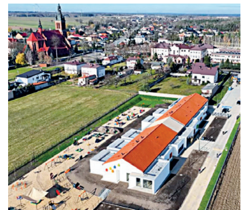
Obiekt żłobka i przedszkola w Kurowicach. Jesień 2025 r.
