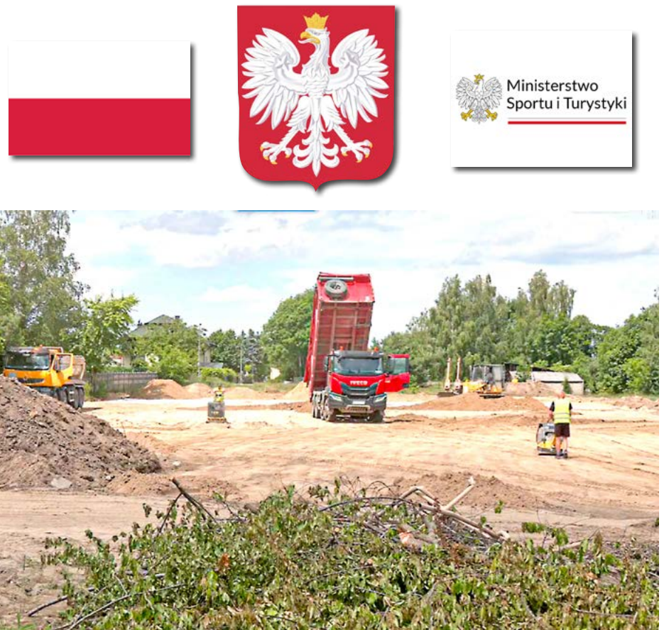
Początek budowy, Bukowiec, 19 czerwca br.
